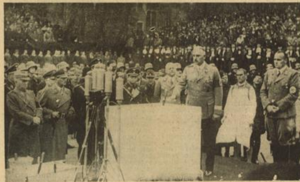
Am Samstag wurde, wie ausführlich berichtet, in der Hauptstadt der Bewegung durch Minister Rust der Grundstein zum „Haus des Deutschen Rechts“ gelegt. — Unser Bild zeigt den Reichserziehungsminister bei der feierlichen Handlung. Links erkennt man Reichsstatthalter Ritter von Epp und den bayerischen Ministerpräsidenten Siebert.
