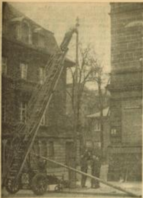
Die Lichtmasten in der Schloßgartenstraße sind in Betrieb genommen worden. Hier werden die letzten Masten aufgerichtet.
