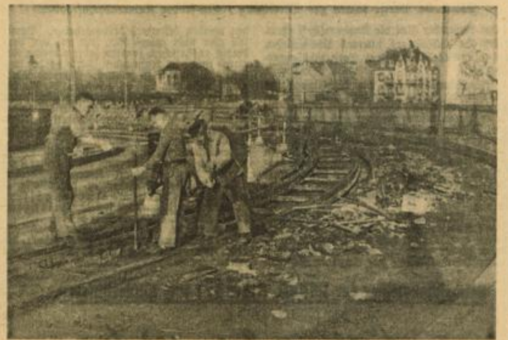
Arbeiten an der Fahrbahn der Hindenburgbrücke. Die Verbesserung der Kurven auf der Fahrbahn der Hindenburgbrücke kann unter einseitiger Aufrechterhaltung des Verkehrs durchgeführt werden.
