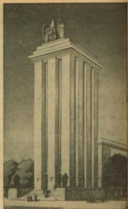
Der deutsche Pavillon auf der Pariser Weltausstellung 1937 Kürzlich wurde mit dem Bau des deutschen Pavillons für die Pariser Weltausstellung 1937 begonnen. Das imposante Monumentalwerk wird eine Fläche von 3864 Quadratmeter einnehmen und eine Länge von 162 Meter aufweisen. Den Eingang bildet ein 34 Meter hoher Turm, der mit Natursteinen aus Süddeutschland verkleidet und von einem gewaltigen Bronzeportal, dem Hohensteintor des Reiches, überhöht wird.
