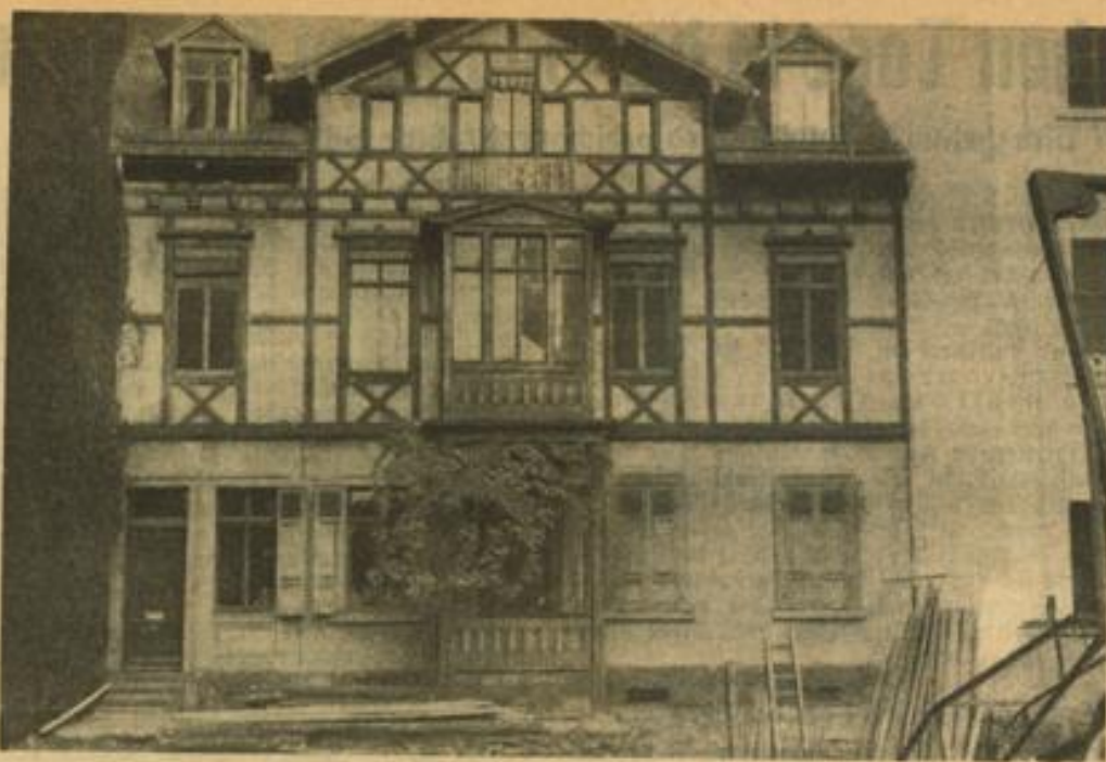
Ein letzter Blick auf ein verschwindendes Haus. Das Fachwerkhäuschen in O 7, das bisher noch als einziges Haus in der Häuserfront der Kanntstraße einen großen Garten besaß und daher zurückgerückt war, wird dem Blick von der Straße aus entzogen.
