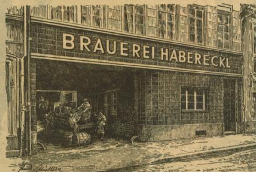
Die Erstellung des „Habereckl“-Hochhauses erforderte den Durchbruch zweier Häuser gegen Q 3 und Q 5. Die vollständig neu hergerichteten Fassaden der Häuser und die im Erdgeschoß vorgenommene Verkleidung mit Klinkerplatten tragen wesentlich zur Verschönerung des Straßensbildes bei. Die eine Einfahrt gegenüber von Q 3 steht unmittelbar vor der Fertigstellung, während an der Ausfahrt auf der gegenüberliegenden Seite noch gearbeitet wird. Zeichnungen: Rudi Möllers (2)
