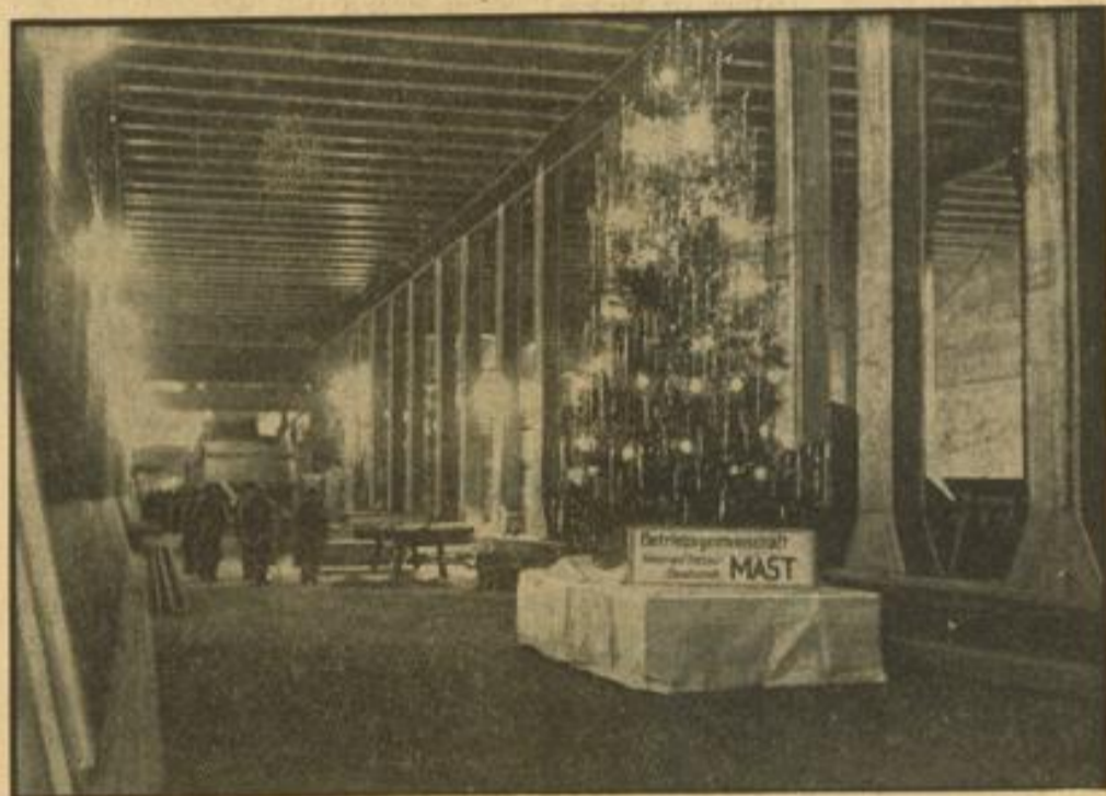
Der Weihnachtsbaum im Tunnel. Die Betriebsgemeinschaft einer Beton- und Tiefbau-Gesellschaft hat ihn zur Freude aller Schaffenden im Tunnelbau der Berliner Nord-Süd-Bahn zwischen Anhalter Bahnhof und Bahnhof Gleisdreieck aufgestellt.
