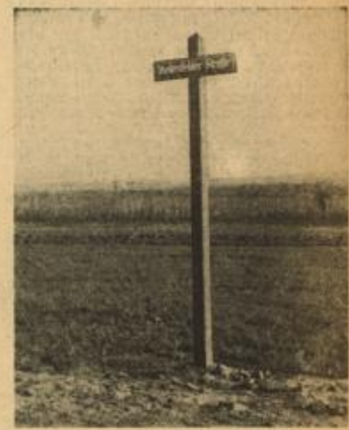
Aufn.: Jütin (7) Kaum ist die Straße am Rande des Baugelbietes in Räfertal-Süd angelegt, wird auch schon das Schild mit dem Straßennamen errichtet. Hinter der letzten Straße dehnen sich weit die Felder.
