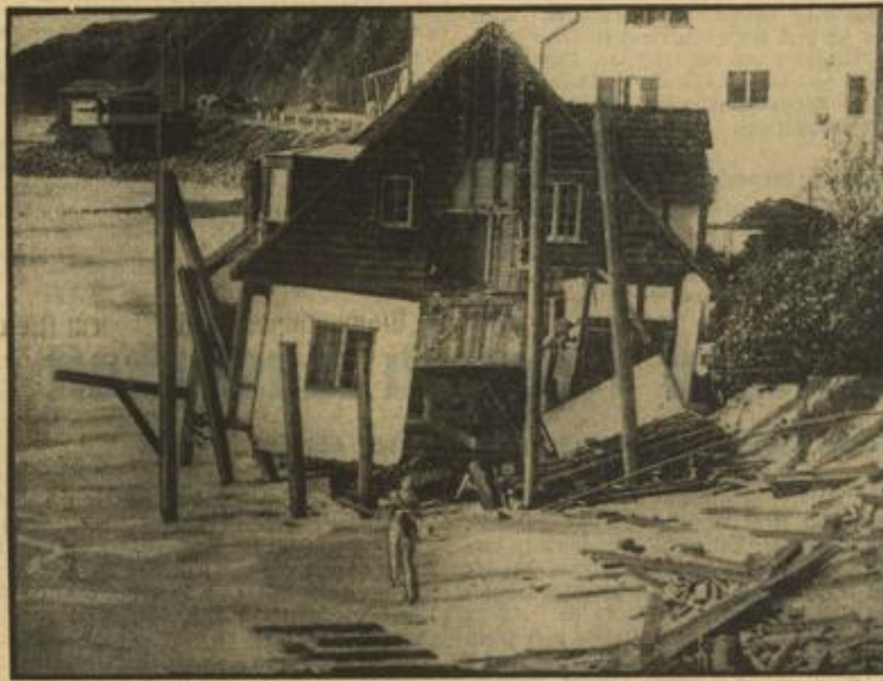
Schwere Sturmschäden an der amerikanischen Westküste. Weltbild (M) Ein zusammengestürztes Haus bei Malibu Beach an der Südküste Kaliforniens. Dort richtete ein Orkan Schäden an, die sich schätzungsweise auf über eine Million Mark belaufen.
