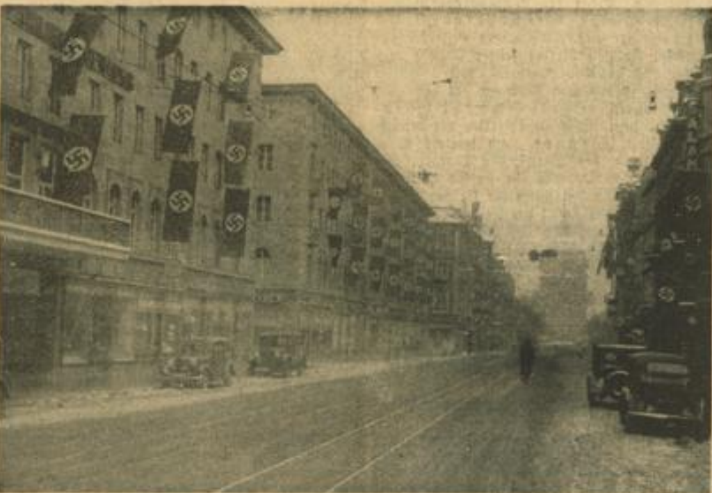
Unsere neuen Plankonhäuser im Flaggenschmuck des 30. Januar. Wie sehr das ganze Volk während der Führerrede am Lautsprecher weite und den Worten des Führers — sei es im eigenen Heim, sei es in den Betrieben, sei es in den allen Volksgenossen zugänglichen Lichtspieltheatern oder in den Gaststätten — lauschte, das beweist das Bild, das am 30. Januar gegen 14 Uhr aufgenommen wurde. Sonst herrscht um diese Zeit in dieser Straße ein solcher Verkehr, daß kaum ein Durchkommen möglich ist, während am Samstag die Straße fast drei Stunden wie ausgestorben war. Aufn.: Lütte
