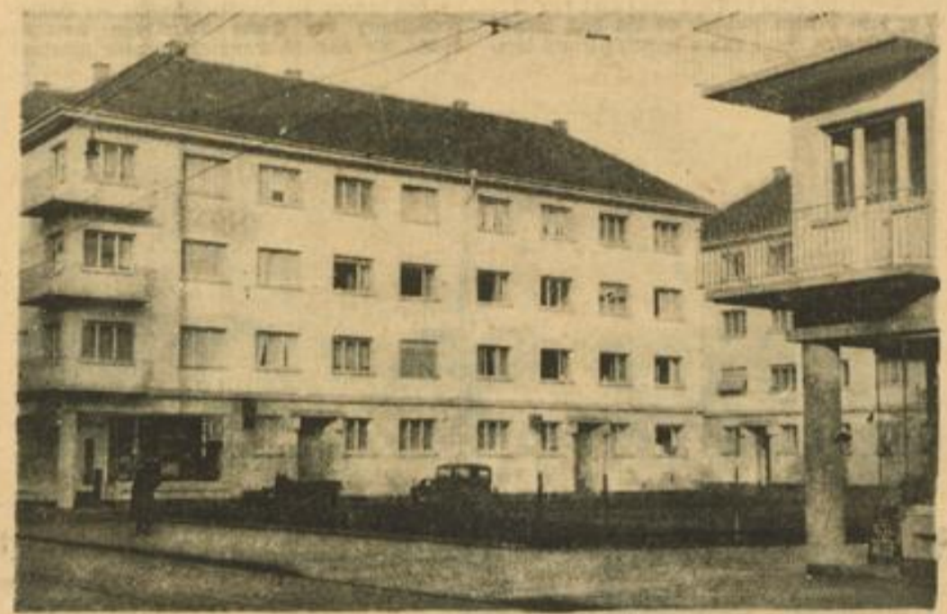
An dieser Stelle standen vor zwei Jahren noch langgestreckte, düstere Mauern einer Fabrik. Inzwischen sind die neuzeitlichen Wohnhäuser erstellt worden...
