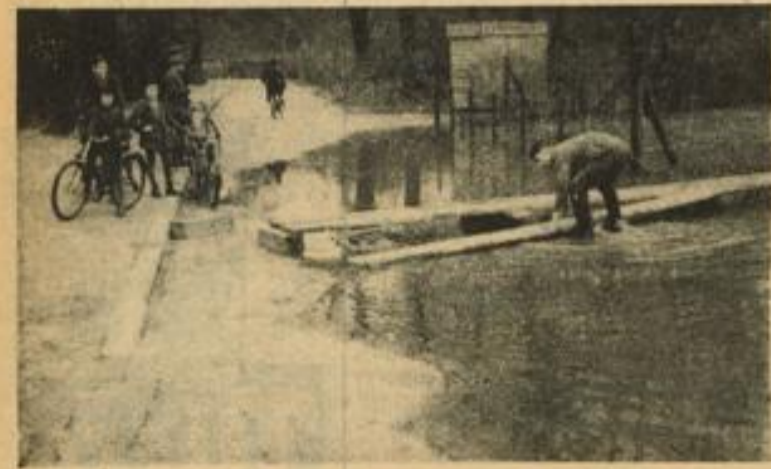
An der Zufahrtsstraße zum Strandbad hat der Rhein auch schon die Fahrbahn erreicht und zum Teil überflutet. Um den rückwärtigen Zugang zum Strandbadrestaurant-Süd begehbar zu erhalten, mußte ein Notstieg errichtet werden.
