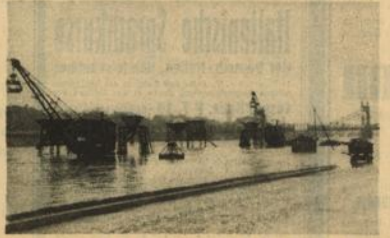
Der Materiallagerplatz bei der Friedrichsbrücke ist so stark von den Fluten des Neckars überspült, daß die Arboleten eingestellt werden mußten.
