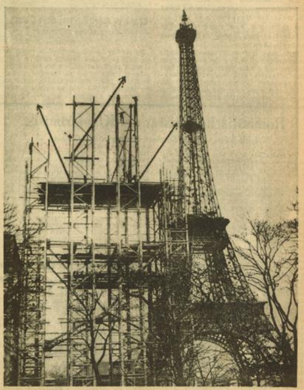
Das Stahlgerippe zum Turm des deutschen Pavillons für die Pariser Weltausstellung wächst jetzt mächtig empor. Die Eisenkonstruktion des übrigen Teiles des deutschen Pavillons ist jetzt nahezu fertig. Das deutsche Haus liegt, wie man sieht, in unmittelbarer Nähe des Eiffelturmes. (Presse-Bild-Zentrale)
