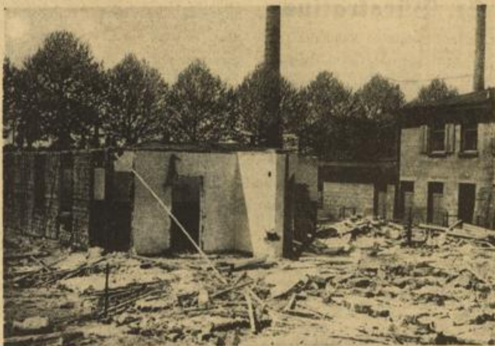
Am Ochsenplatz werden die Baracken abgetragen, die bisher als Wohnungen dienten. Auf dem geräumten Platz wird der Parkplatz für den Ferngüterverkehr entstehen.
