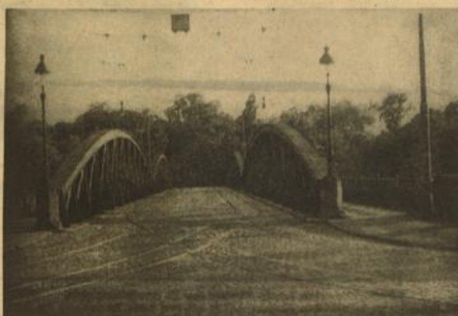
Der Lindenhof-Uebergang, von der Stadtseite gesehen Aufn.: Hagener (2)
