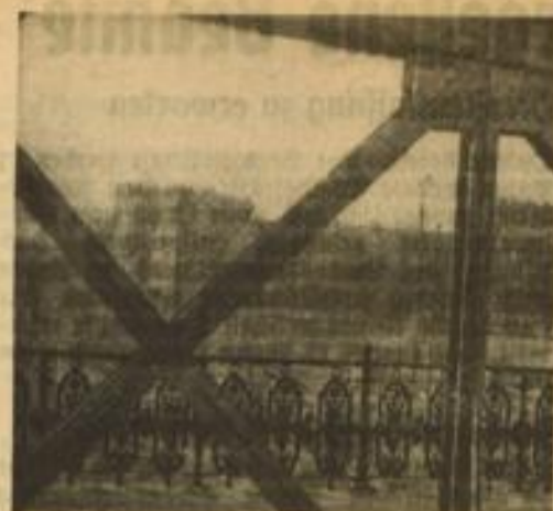
Durch das Trägergerüst des Lindenhof-Ueberganges hat man einen schönen Blick auf das Schloß
