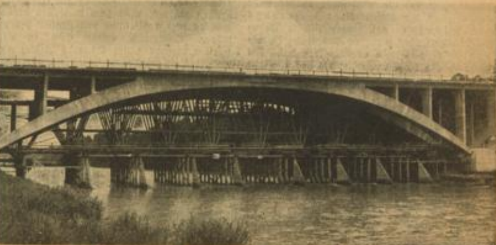
Die Donaubrücke der Reichsautobahn bei Lulpeim vor der Vollendung Die Donaubrücke der Reichsautobahn München-Ulm bei Lulpeim ist ein Meisterwerk deutscher Baukunst und geht jetzt ihrer Vollendung entgegen
