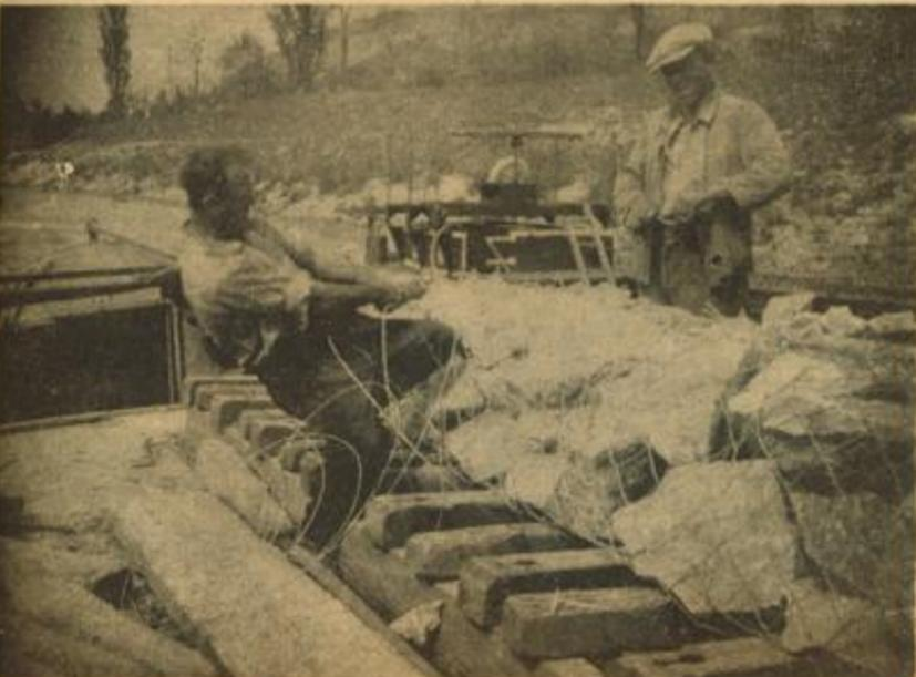
Einbinden der Steine zu einer Steinsekwurk. Rechts vom Brückenschiff das Steintransportfahrzeug
