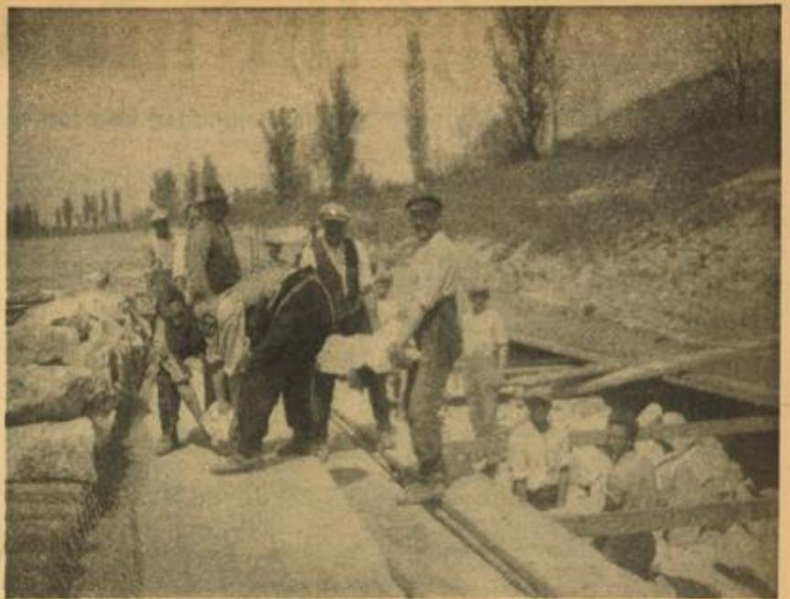
Ausladen der z. T. über 100 Kilo schweren Steine aus dem Steintransportschiff und Aufsetzen der Steine auf ein Zinkdrahtgellecht
