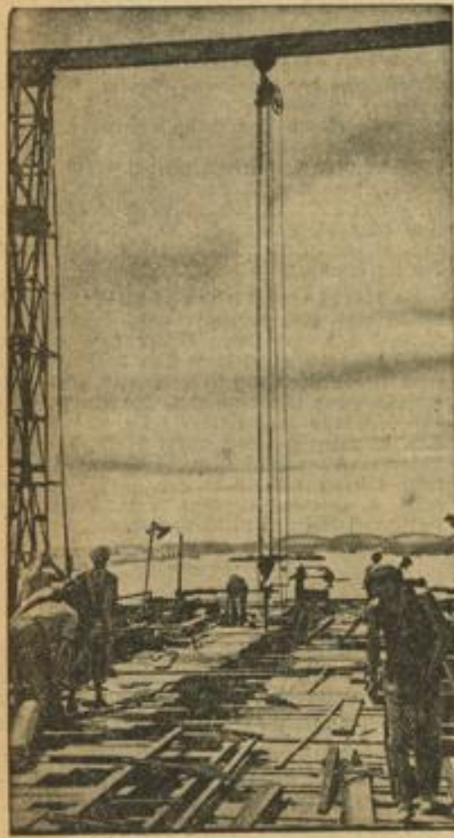
Die Reichsautobahnen wachsen Arbeiten auf dem mittleren Strompfeiler der im Bau befindlichen Schrägseilbrücke in Hamburg, die eine der größten Brücken der Reichsautobahnen wird. Sie gehört zur Strecke Hamburg-Bremen. Weibild (M)
