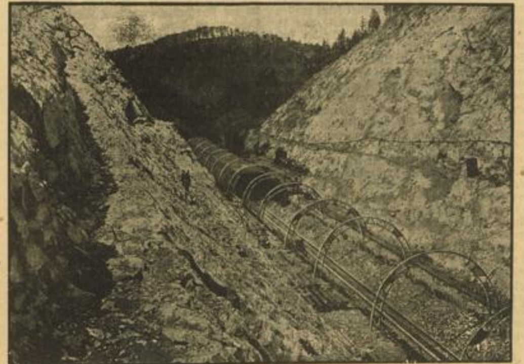
Der größte Bergdurchstich in Europa Der 274 Meter lange „Schönbauer Tunnel“, der unter einem 600 Meter hohen Bergzettel hindurchführt, war seit Jahr- zehnten schon durch den Kohlenabbau unmittelbar unter der Tunnelanlage gefährdet. Riesige Risse und Felsstürze zogen die Strecke in Mitleidenschaft. Der einzige Ausweg aus dieser ständig drohenden Gefahr war schließlich das Projekt, das Waldenburger Gebirge an dieser Stelle abzutragen und die Züge, anstatt durch einen Tunnel, durch eine tiefe Felsenröhre fahren zu lassen. Heute ist der ehemalige Schönbauer Tunnel der tiefste Bahntunnel Deutschlands. Unser Bild zeigt den Abbruch des letzten Teiles. Weltbild (M)
