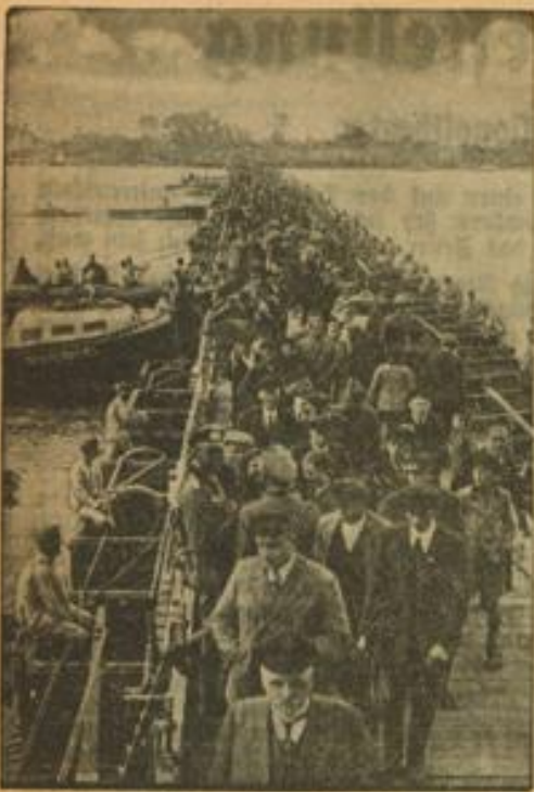
Pioniere bauten eine Brücke über die Elbe. Blick auf die von Fußgängern belebte Pionierbrücke über die Elbe, die von den Pionier-Bataillonen 20 und 50 bei dem Dörlchen Alt-Garge gebaut wurde. Die Brücke wurde während einer vierwöchigen Übung bei Blockade über die Elbe geschlagen und verbindet Mecklenburg mit Hannover. Weltbild (M)
