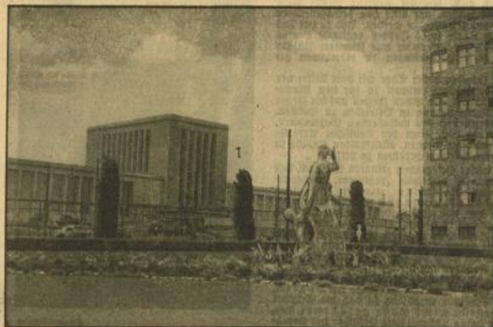
Die Berliner Messestadt wächst. Blick auf die nahezu vollendete neue Ausstellungshalle in der Berliner Messestadt. Weltbild (M)
