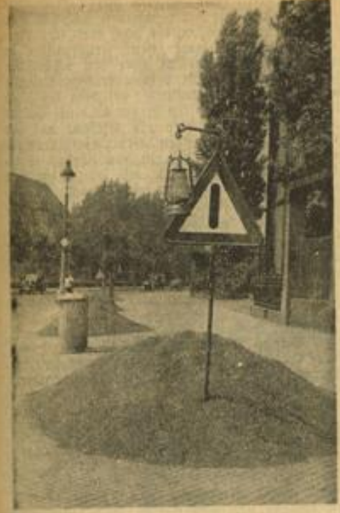
Ausbesserung der Gehwege
