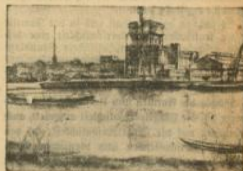
Gewaltige Anlagen, und doch nur ein kleiner Ausschnitt aus dem großen Opelwerk am Main: Das hochragende Kraftwerk — stark genug, eine mittelgroße Stadt zu versorgen; die langgestreckte Schmiede mit ihren 26 Mammuthämmern; der eigene Hafen mit seinem 250 Meter langen Kai
