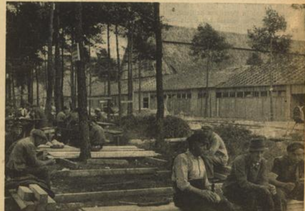
Bei einer Mittagspause der Arbeiter in der neuen Nürnberger KdF-Stadt
