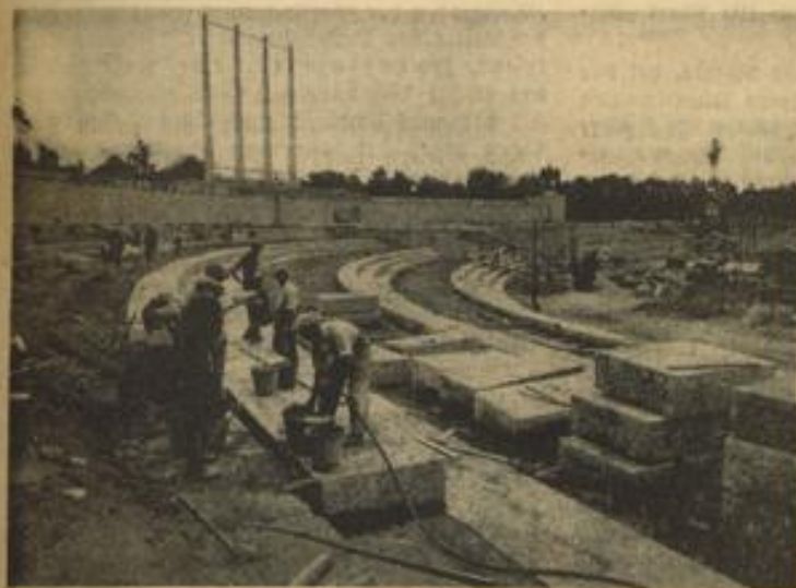
Links: Die Rasenterrassen der Luitpold-Arena werden jetzt in Stein gebaut. — Rechts: Ein Blick auf die Arbeiten an der „Großen Straße“
