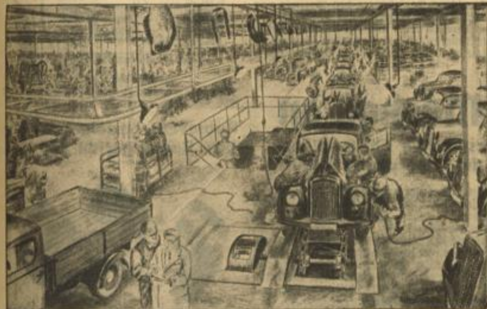
Die Riesenhalle des Opel-Lastwagenwerkes Brandenburg, 25 000 Quadratmeter groß. Quer zum Montageband, das auf den Beschauer zuläuft, münden von links dreizehn Maschinenstraßen, in denen die gesamte Bearbeitung erfolgt. Zeichn. Hans Wendt (2) R. Enders (1)
