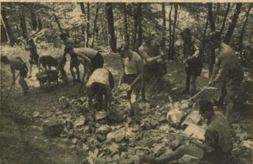
Freude an der Arbeit. Am Vormittag arbeiten die Teilnehmer des Lagers freiwillig am Bau eines Weges.
