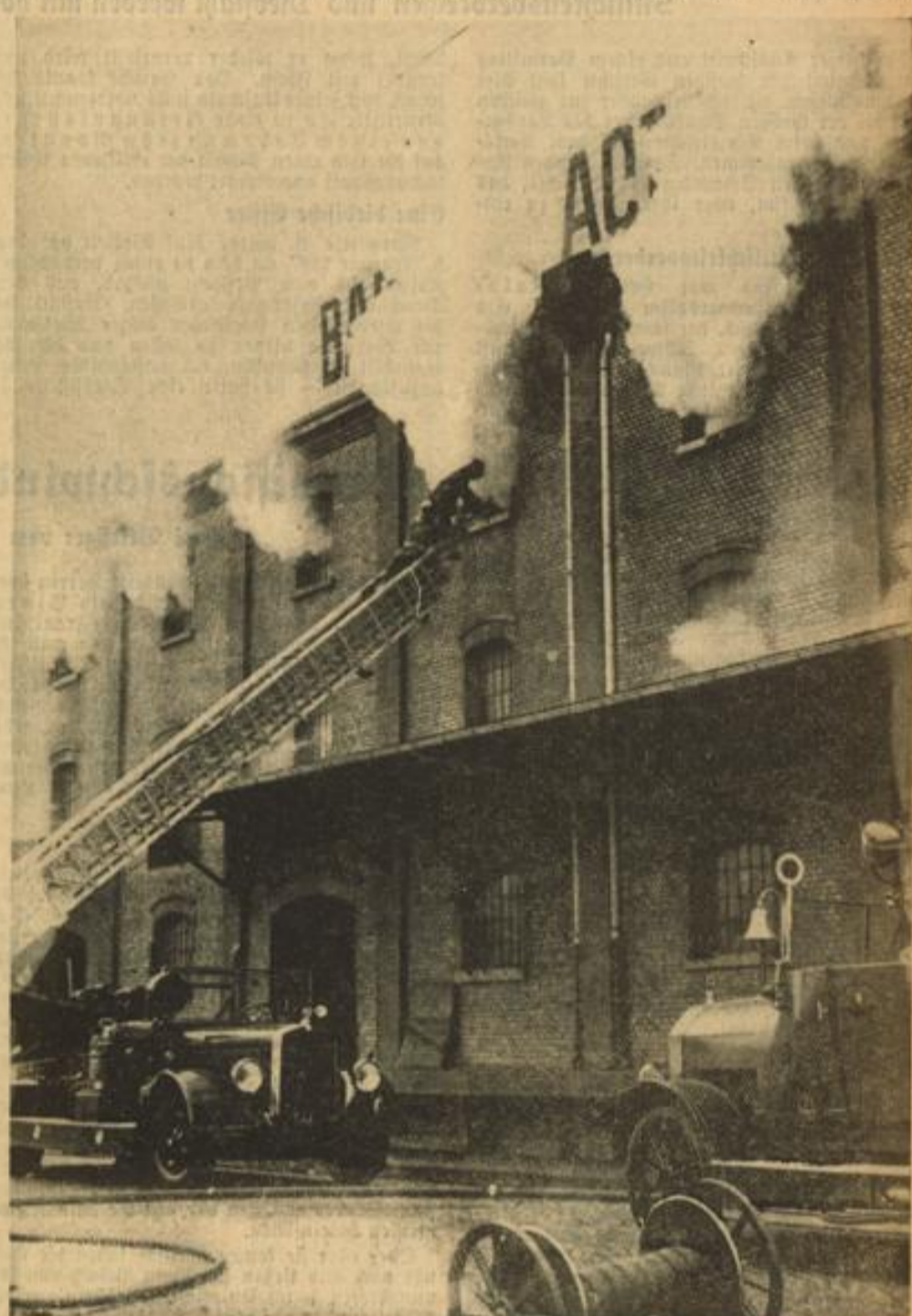
Ans allen Fenstern drangen bei Eintreffen der Löschzüge dicke Rauchwolken aus der Lagerhalle, und durch alle Fenster mußte man die unsichtbaren, im Innern der Halle wütenden Flammen bekämpfen. Die in dem dort lagernden Tabak reiche Nahrung fanden.
