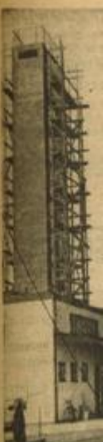
Mit Gerüsten ist Hallen verkleidet den Scheib...
