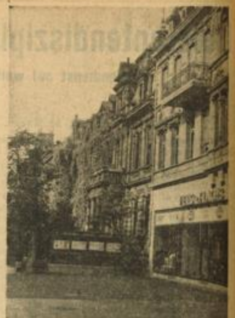
Eine zweite Bresche ist in die Front der Vorgärten gelegt und eine weitere Etappe auf dem Wege der Umwandlung des Kaiserrings in eine Geschäftsstraße gewonnen.
