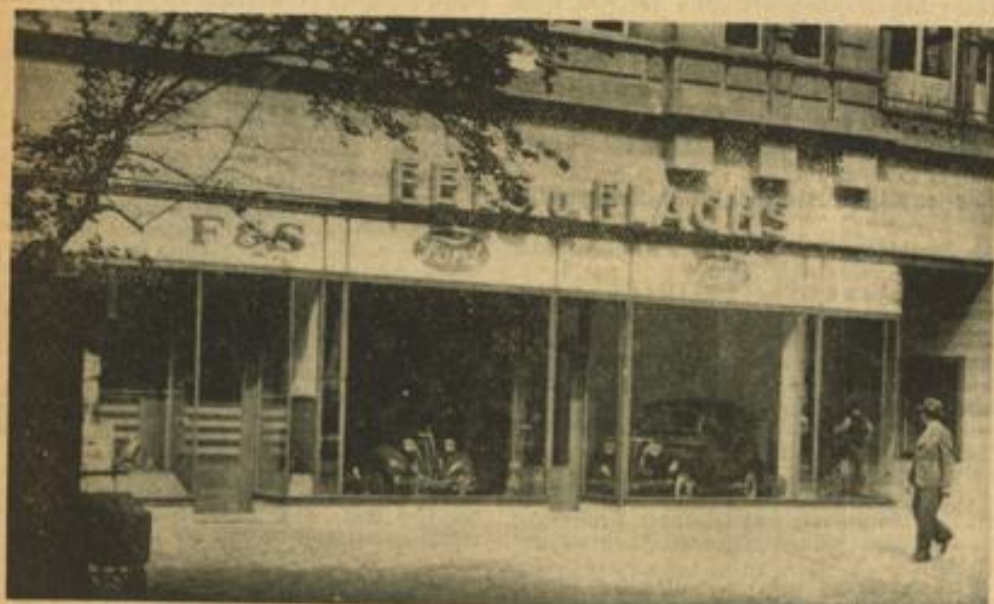
Das Haus N 7, 10 nach dem Umbau
