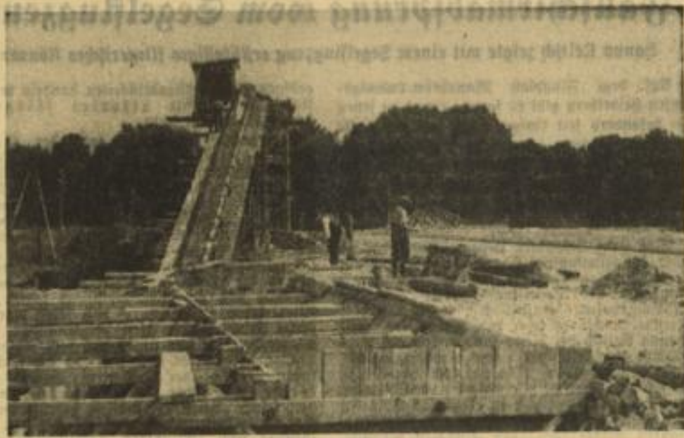
Ein lautendes Band führt über diesen Förderturm, der für die Erdarbeiten bei der Umlegung der Sedenheimer Straße erstellt werden mußte.
