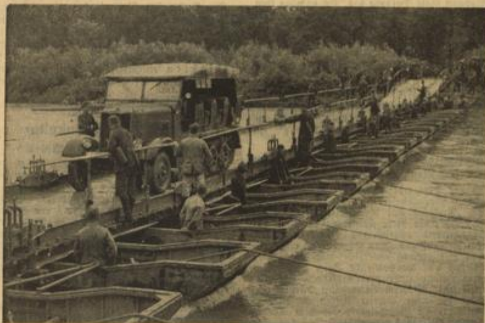
So reiht sich Ponton an Ponton, um die Ueberquerung des Flusses zu ermöglichen
