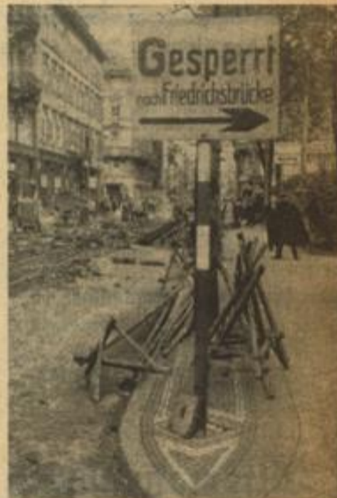
Die Gleisverlegungsarbeiten in der Breitenstraße machen die Umleitung des Straßenverkehrs erforderlich, der zunächst nur um das Paradeplatzquadrat herum umgeleitet zu werden braucht, da man mit den Verlegungsarbeiten lediglich das Straßenstück zwischen D 1 und O 1 in Angriff genommen hat.
