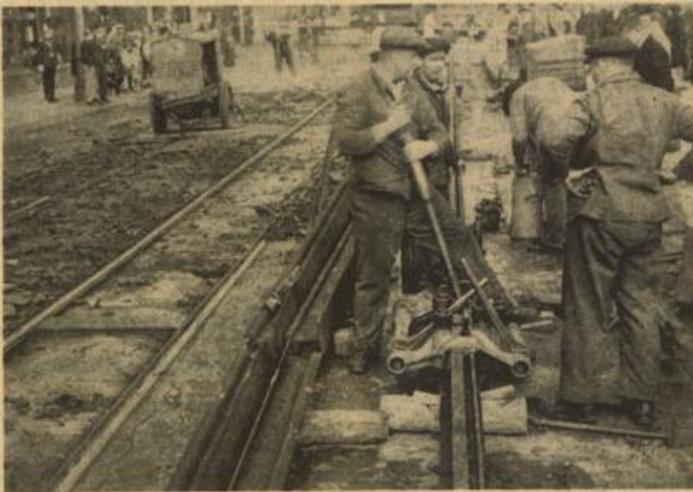
Am Paradeplatz wird jetzt in der Breitenstraße kräftig gebuddelt, denn man arbeitet mit Preßluftmeißeln, um die Fahrbahndecke zu sprengen und die alten, abgenutzten Straßenbahngleise herausnehmen zu können. Gleichzeitig bereitet man die neuen Gleise vor, die man auf die Länge eines Häuserblocks zu einem ununterbrochenen Stück zusammenschweißt. Hier wird gerade die Schweißung der neuen Schienen vorbereitet. Aufnahmen: Hans Jütte (2)
