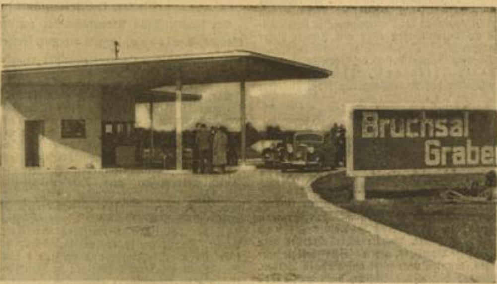
Die neue Tankstelle bei Bruchsal Aufnahme: Fr. Haas
