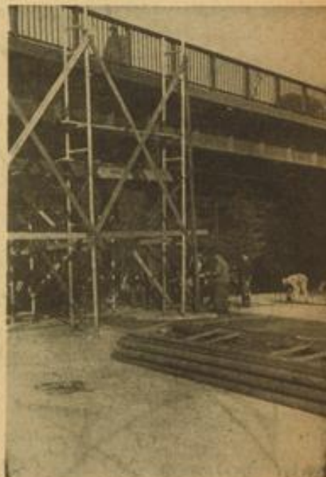
Kurz vor der Eröffnung wurden die letzten Gerüste beseitigt
