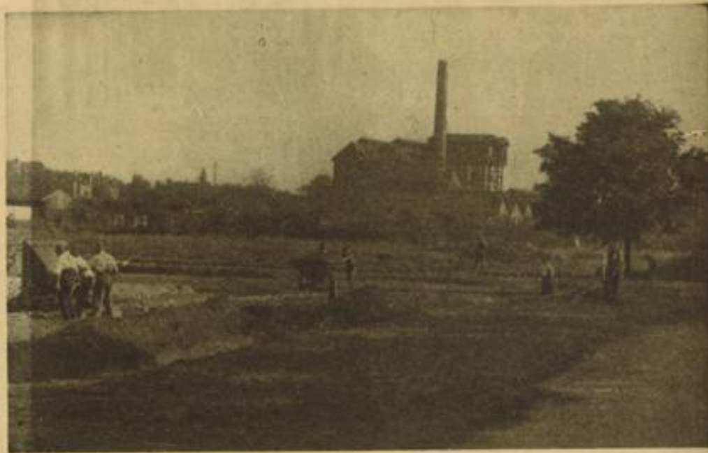
Auf diesem Gelände entsteht der neue Teil des Mannheimer Friedhofs, der sich an den bestehenden Hauptfriedhof anschließt. Die auf dem Gebiet befindlichen Kleingärten und Gärtnerreien mußten geräumt werden, um die Anlage des Friedhofs zu ermöglichen. Aufnahmen: Hans Jütte (2)
