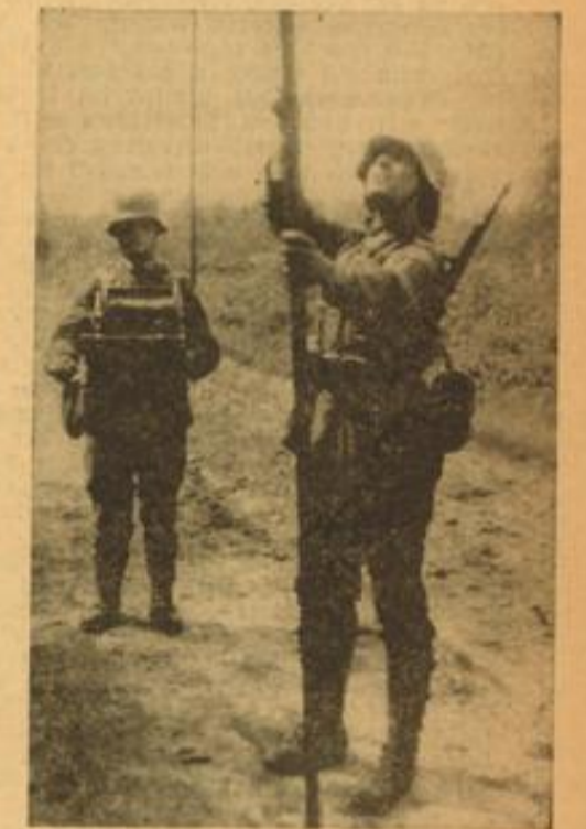
Die Leitung wird verlegt WNZ (5)
