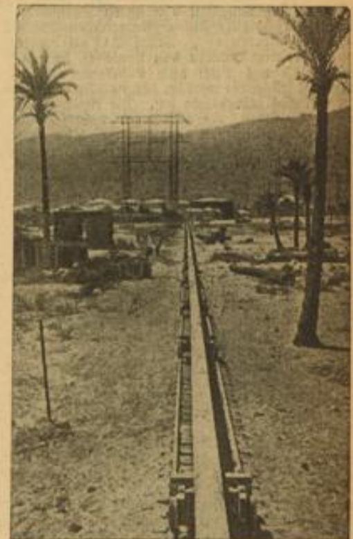
Arabische Aktivisten haben die von Mossul im Irak nach Haifa an der Palästina-Küste führende Petroleumleitung an drei verschiedenen Stellen zur Explosion gebracht. Die Irak-Pipeline, wie die Petroleumleitung Mossul-Haifa genannt wird, ist für die Engländer deshalb von besonderer Wichtigkeit, da sie zum wesentlichen Teil die englischen Flottenstreitkräfte im Mittelmeer mit Öl versorgt. So zieht sich diese Ölleitung Hunderte von Kilometern durch die Wüste. (Scherl Bilderdiens-M)
