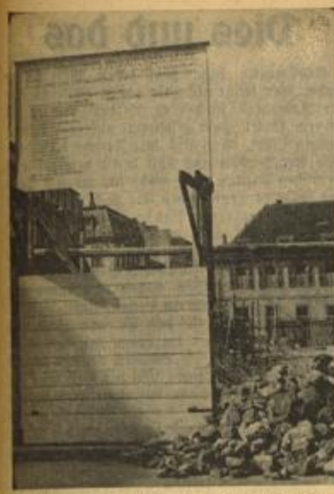
Die Arbeiten an der Erstellung des neuen Technischen Verwaltungsgebäudes auf dem Gelände des Plankendurchbruchs II machen jetzt rasche Fortschritte, nachdem ein großer Teil der Fundamentierungsarbeiten schon fix und fertig ist. Die aufgestellte Tafel mit der Angabe des Bauherren und der leitenden Firmen dürfte bald nach und nach ergänzt werden. Aufnahme: Jütte
