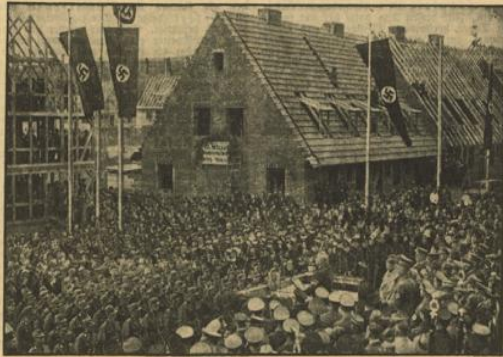
Dr. Ley bei der Richtfeier einer Vierjahresplan-Siedlung Reichsorganisationsleiter Dr. Ley hält die Festansprache in der Siedlung Sontra (Bezirk Kassel), die aus 800 Wohnungen besteht und jetzt im Rohbau fertiggestellt wurde.
