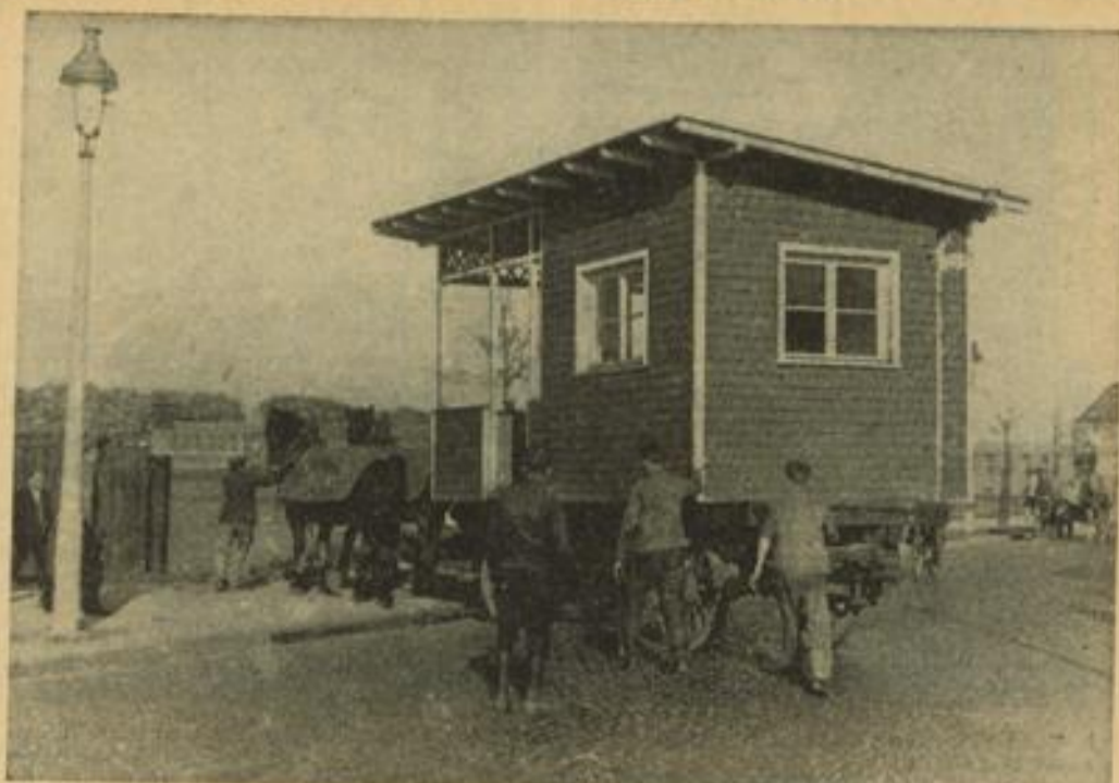
Gewiß kein alltäglicher Anblick. Aber wenn schon einmal ein Gartenhaus von einem Platz zum anderen gebracht werden muß, dann bleibt nichts anderes übrig, als das „Gebäude“ auf ein Fahrwerk zu verladen und es auf Rädern an seinen neuen Aufstellungsplatz zu bringen. (Aut.: Hans Jette)
