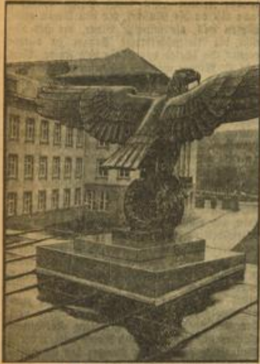
Ein soldatischer Bau Teilansicht vom Neubau des Dienstgebäudes für das Generalkommando des III. Armeekorps in Berlin-Grünwald mit dem zweiseitigen, feuervergoldeten Hakenkreuz, dem Symbol der neuen deutschen Wehrmacht. Weltbild (M)
