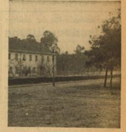
Aufnahme: Jütte Hier wohnen am Rande des Käfertaler Waldes in der Gartenstadt Waldhof in ruhiger Lage alte Leute. Da die Nachfrage nach solchen Wohnungen recht groß ist, werden im Anschluß an die bestehende Häuserzeile weitere Kleinwohnungen für alte Leute errichtet.
