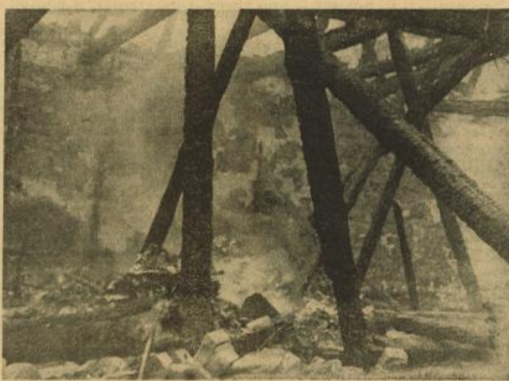
Das obere Geschöß des Seitenbaues an der Brandstelle Rheinoldstraße 56. Zerstörte Lebensmittel und verkohlte Balken in wirrem Durcheinander.
