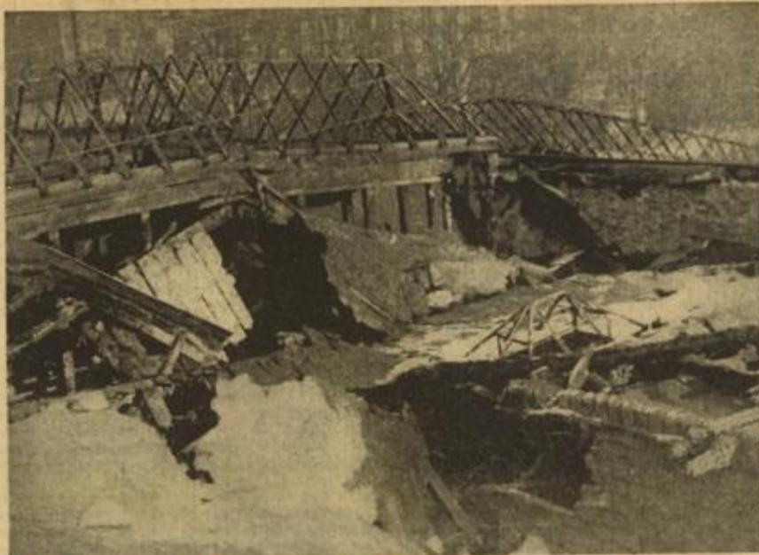
Blick über die Brandstätte am Dienstagfrüh, kurz vor Beginn der Aufräumungsarbeiten. Ueber das eingebrochene Dach ragen die eisernen Dachreiter hervor, die durch die Hitze verbogen wurden.
