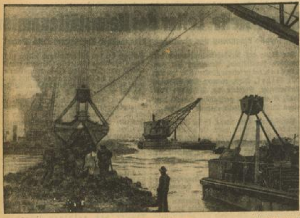
Die Trockenlegung des Zaijlersees. Der Abschluß der bisherigen Trockenlegung des Zaijlersees; das letzte Stück wird in dem Deich geschlossen.
