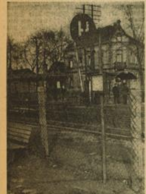
Solche Haltestellenschilder trifft man an allen Haltestellen der Rheinischer Straßenbahn-Strecke. Die Farbe der Schilder an den gewöhnlichen Haltestellen ist gelb, während die Schilder der Teilstreckenzugängen in roter Farbe gehalten sind. An den Masten der Teilstreckenzugängen sind außerdem noch Fahrplankarten angebracht.
