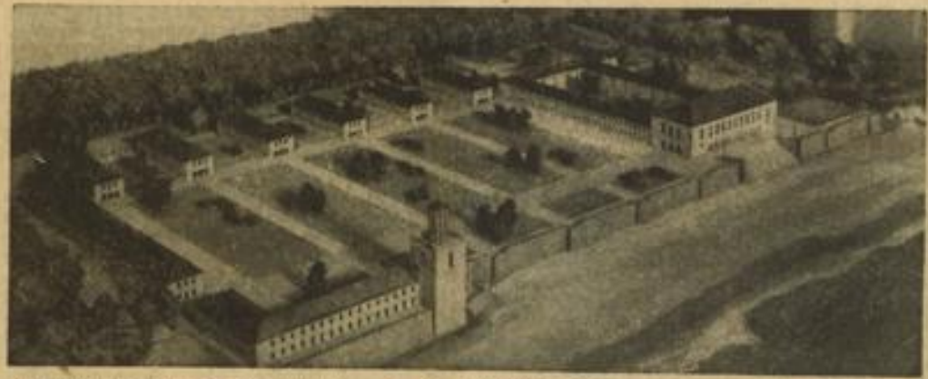
Am kommenden Samstag Grundsteinlegung der 10 Adolf-Hitler-Schulen. Scherl-Bilderdienst-M
