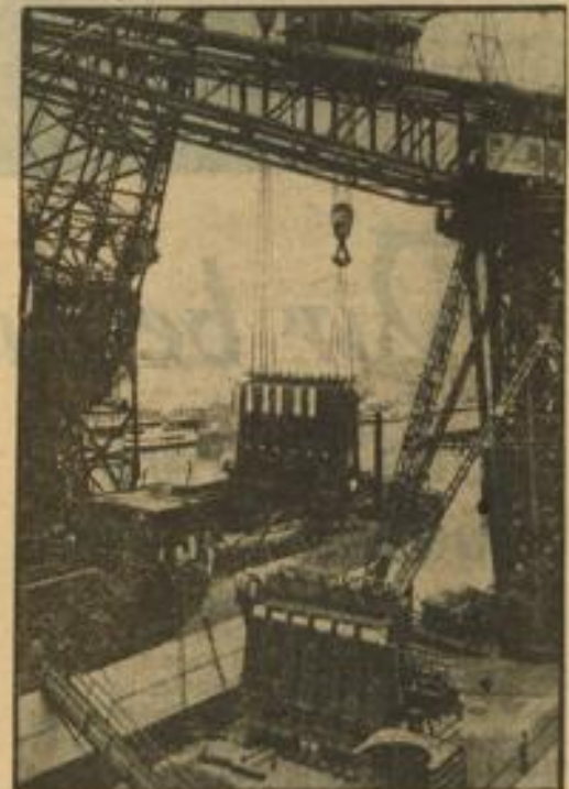
Deutsche Werkarbeit für USA Auf der Friedrich-Krupp-Germaniawerft in Kiel-Gaarden wird für die Standard Oil Company of California eine der größten Motortankschiffe, „China“, (17 632 Tonnen), erbaut. Auf unserem Bild erfolgt der Einbau der Dieselmotoren. Weltbild (M)
