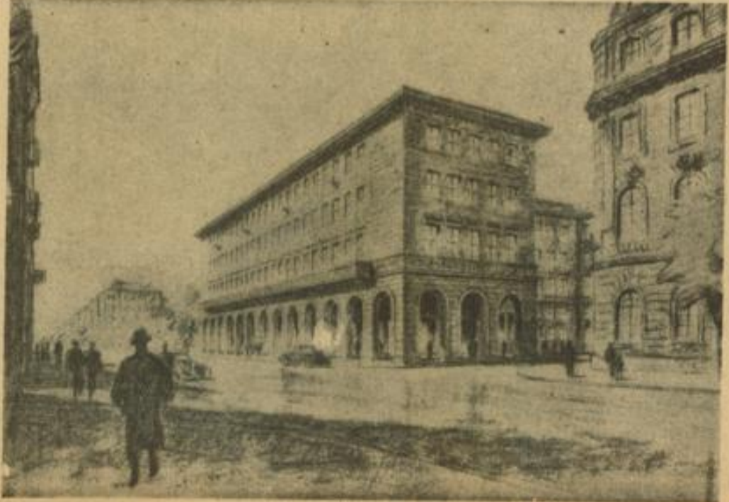
Unser Bild zeigt das im Bau befindliche technische Amtsgebäude in E 5. Rechts das bisherige Börsengebäude, in dem die Hochschule für Musik und Theater eine Heimstätte finden wird
