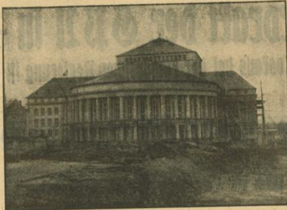
Das Grenzlandtheater in Saarbrücken geht seiner Vollendung entgegen. Das Grenzlandtheater, ein Geschenk des Führers an die Stadt Saarbrücken, ist nimmer bis auf die Innenausstattung fertiggestellt. Das Bauwerk, eine Schöpfung des Berliner Architekten Prof. Baumgarten, liegt unmittelbar am Ufer der Saar und wird noch in diesem Jahre seiner Bestimmung übergeben.
