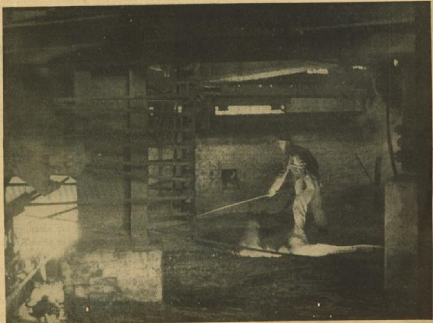
Am Abstich eines Hochofens
