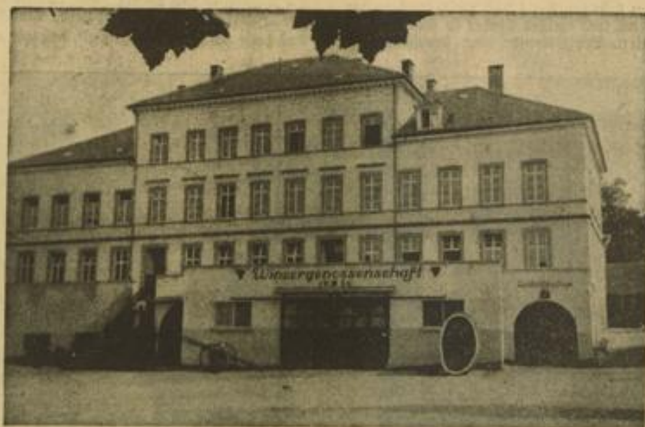
Schriesheims Zehntkeller und Schulhaus
