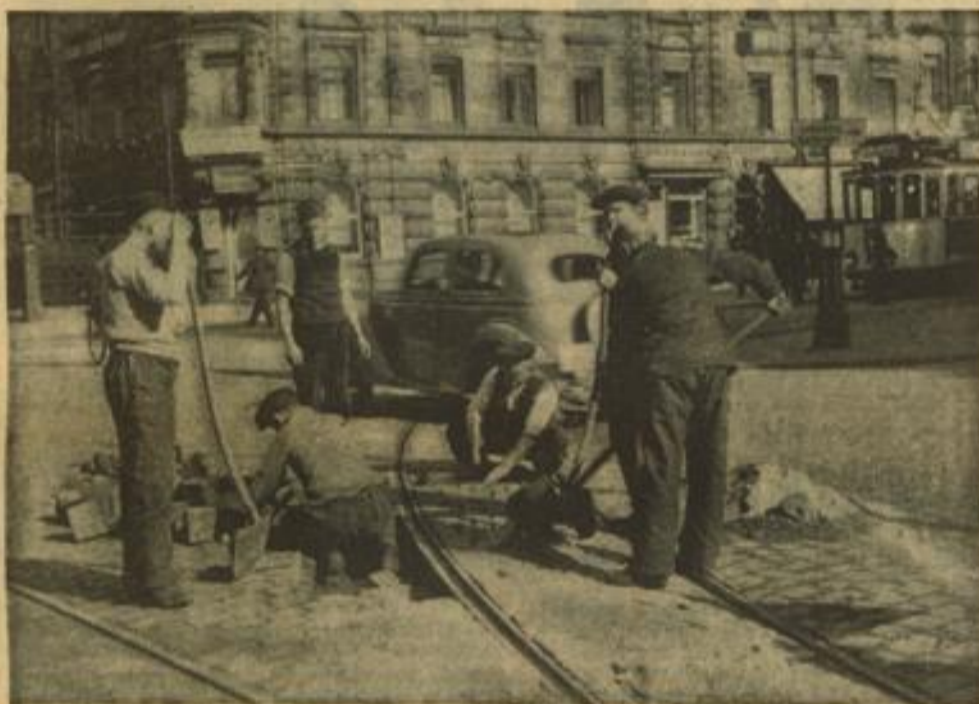
Gleisverbesserungen sind bei Kreuzungen mehrerer Straßenbahnlinien, wie hier am Tattersall, besonders oft notwendig. Aufn.: Wilh. M. Schatz
