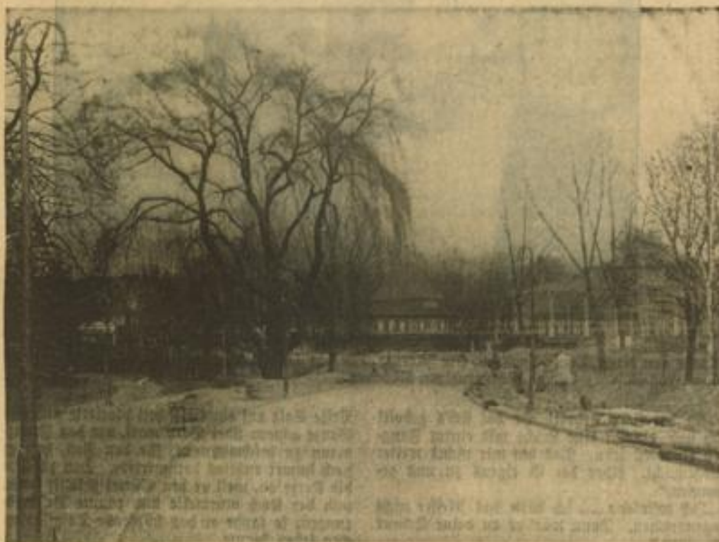
Durch die Umgestaltungsarbeiten an der Reichsautobahneinfahrt war die Rennwiese mit der dazugehörigen Gäststätte in den letzten Monaten nur auf Umwegen zu erreichen und bildete eine schwer zugängliche „Oase“. Das wird in diesen Tagen anders, denn mit Hochdruck arbeitet man an der Fertigstellung der neuen Zufahrtsstraße, die von der Straße „Am oberen Lutsenpark“ aus in schön geschwungenem Bogen direkt zum Haupteingang der Rennwiese führt.
