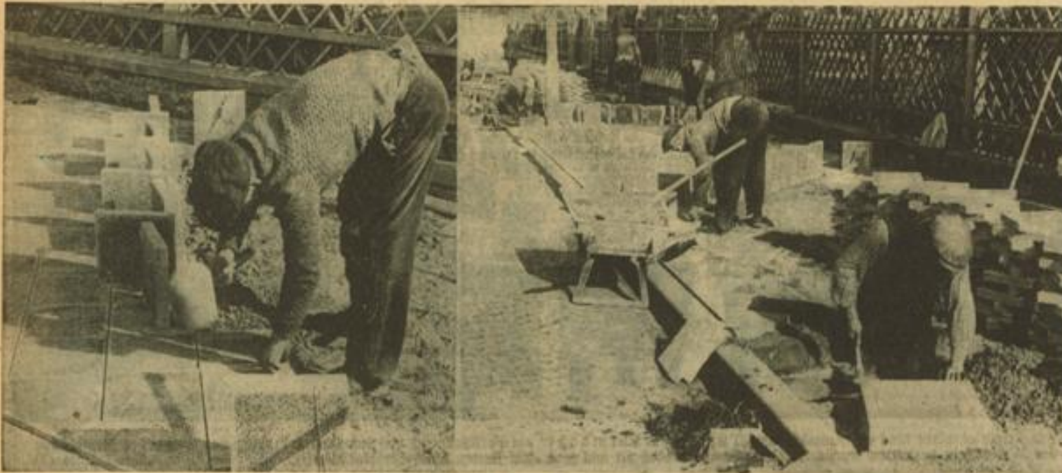
Die Herstellung der Gehwege ist gegenwärtig an vielen Stellen im Gang. Es wäre sehr zu wünschen, wenn die überall noch nicht mit Platten belegten Gehwege baldigst einen Plattenbelag erhalten würden, da dadurch das Stadtbild wesentlich gewinnt. Aufn.: Jütte (3)
