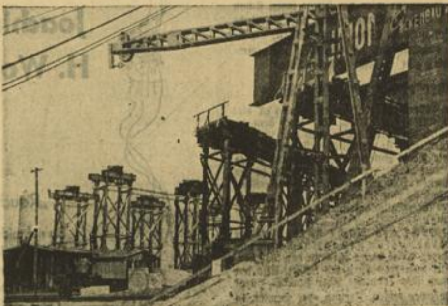
An einer Baustelle der Reichsautobahn. Aufn. Engels
