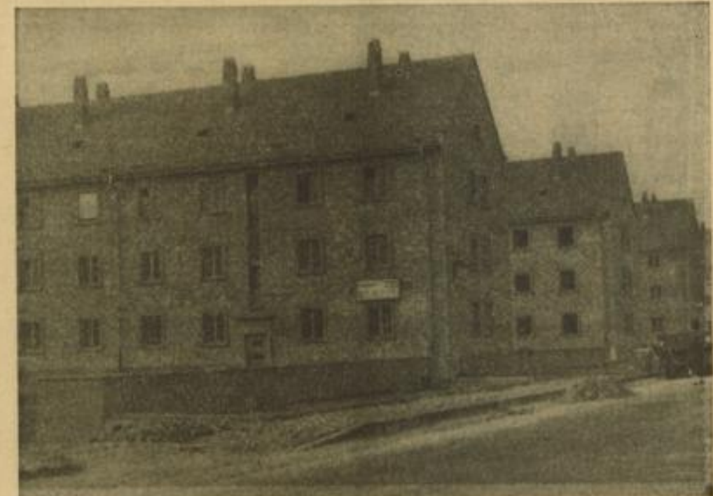
In der Unteren Mülhau sind wieder neue Bauzeilen durch die Gemeinnützige Baugesellschaft erstellt worden, die in den letzten Tagen ihre ersten Mieter erhielten und die bis zum 1. Mai vollständig bezugsfertig sind. Aufnahme: Jütte
