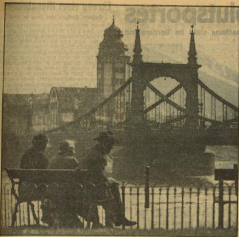
Blick auf die Friedrichsbrücke und die Hauptfeuerwache In wenigen Tagen werden die ersten vorbereitenden Arbeiten für die Verbreiterung der Friedrichsbrücke aufgenommen.
