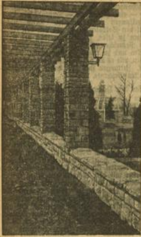
Ein Rundgang, der aus helmsischem Ruhrsandstein errichtet wurde und einen ständig wechselnden Blick in den „Großen Blumenhof“ gewährt. (Scherl-Bilderdienst-M)
