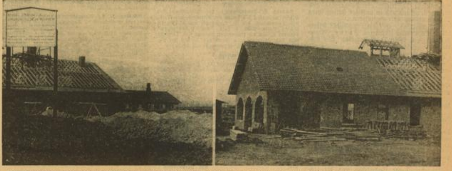
Auf der Friesenheimer Insel sind im Auftrag der Stadtverwaltung Mannheim für das Ernährungshilfswerk Schweineställe im Bau, die demnächst vollständig „betriebsfertig“ werden. Kein Küchenabfall darf in Zukunft mehr umkommen, denn das Ernährungshilfswerk kann diese Abfälle sehr gut gebrauchen und mit der Schweinepasta beitragen, die Nahrungsfreiheit unseres Volkes sicherzustellen. Aufn.: H. Jütte (2)
