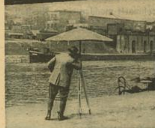
Bei den Vermessungsarbeiten an der Friedrichsbrücke wurde jeweils an die Querträger die Meßlatte angelegt und diese von dem Nivellierinstrument aus anvisiert. Aufn.: H. Jütte
