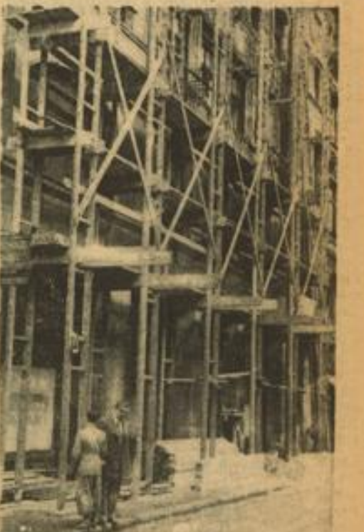
Seit einigen Wochen befinden sich an dem früheren BBC-Haus in O 4 Baugerüste. Das Haus ist in den Besitz der Deutschen Arbeitsfront übergegangen, die es für ihr Berufserziehungswerk umbauen läßt.
